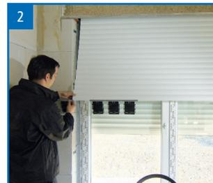
Montieren Sie unsere Wellenclipverbinder am Rollladenpanzer.
