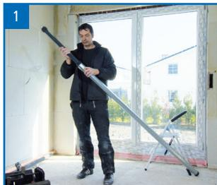
Montieren Sie den Rollladenmotor.
