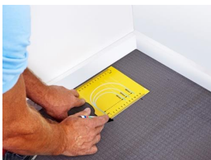
Pasižymėti atstumus tarp kabelių
