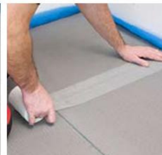
Ant plokščių sujungimų užklijuokite Isolecta juostą (kitą dieną).
