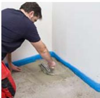
Plokštėms priklijuoti prie pagrindo naudokite plytelių klijus.
