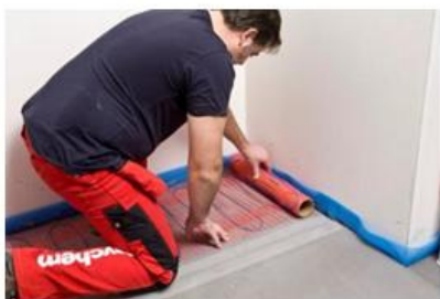
Pagal T2QuickNet montavimo instrukciją paklokite šildymo kilimėlį.
