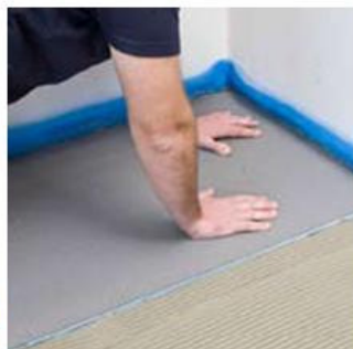
Paklokite Isolecta plokštę.
