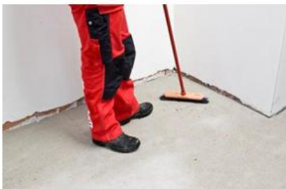
Išvalykite pagrindą nuo dulkių ir purvo
